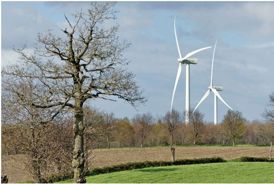
Parc éolien de Neuvy-Bouin à Trayes
