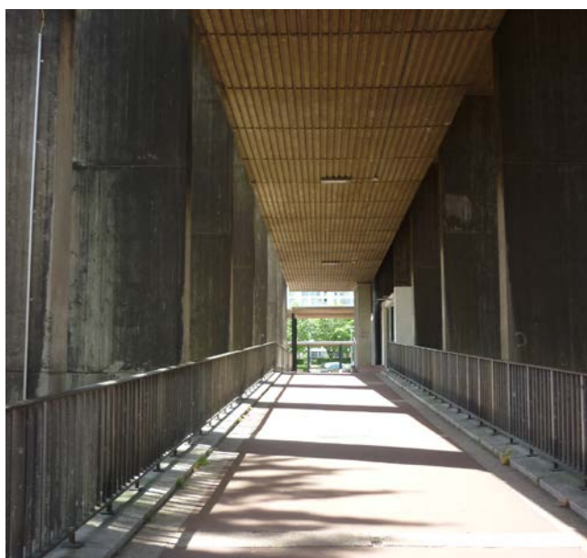
Vue d'une partie du passage couvert.
