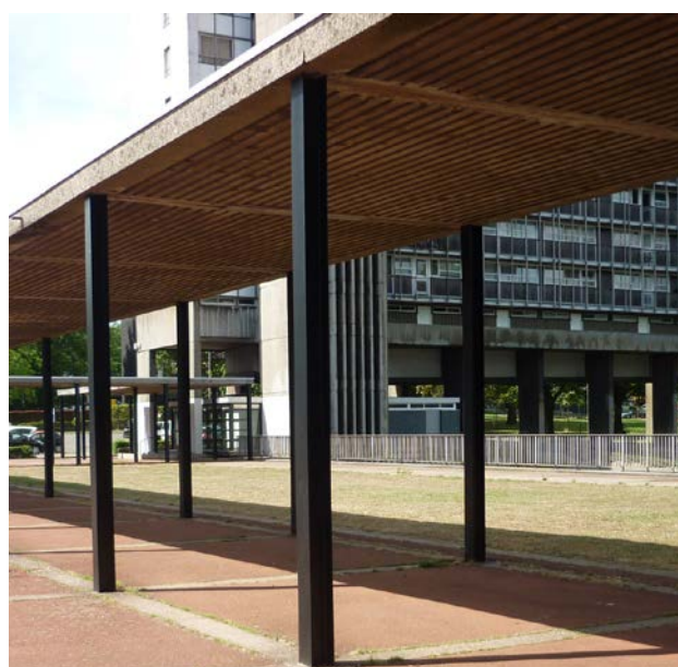
Vue de la continuité du passage couvert sur la place haute.
