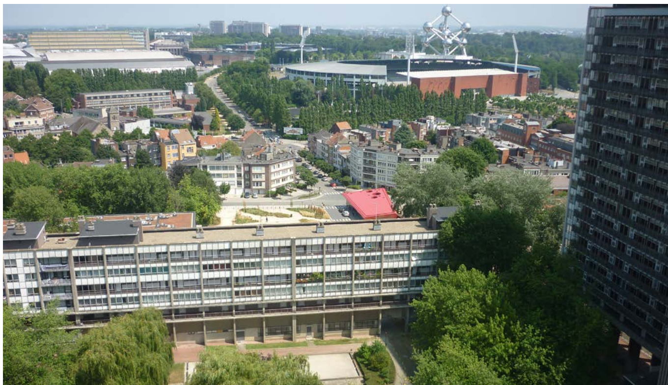
Vue depuis le dernier étage de l'immeuble 1 de la Cité Modèle. Au fond, l'Atomium.
