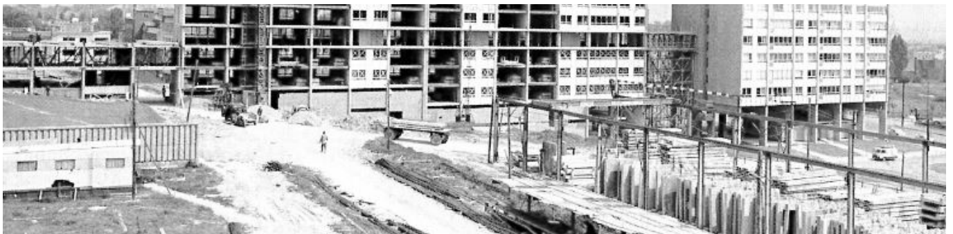
Fig 1. Photographies de la construction de la Cité Modèle. A l'avant plan, le chantier de préfabrication. (Source: Revue «La technique des travaux», 1966.)
