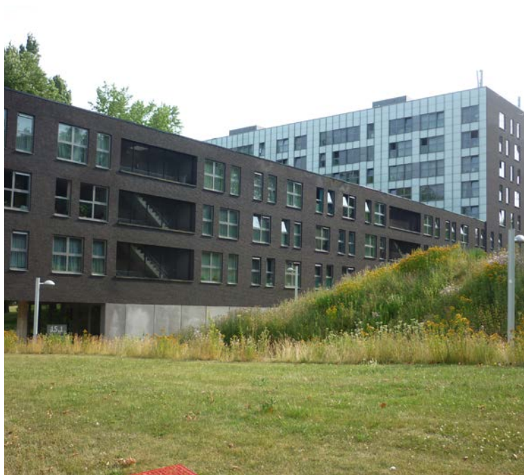
Vue des nouveaux bâtiments.
