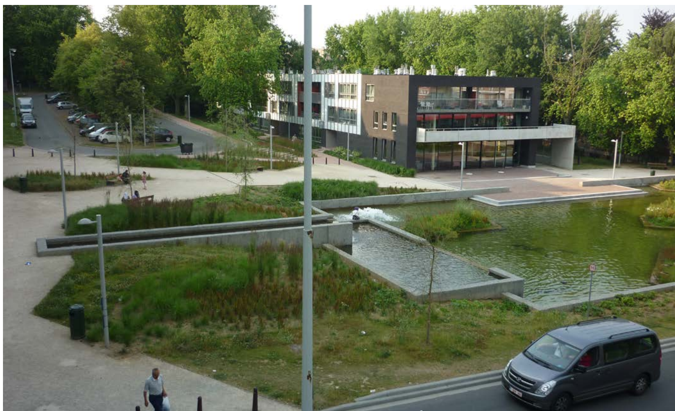
Vue du bassin à l'entrée de la Cité. E. Simorre, 2015.
