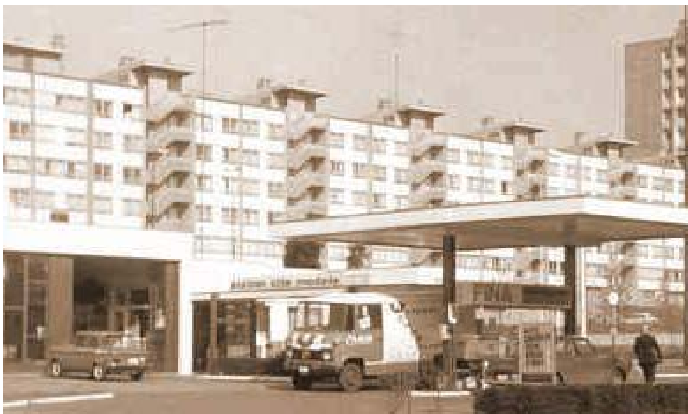
Vue de la station de service à l'entrée de la Cité. Le Foyer Laekenois, 1970.
