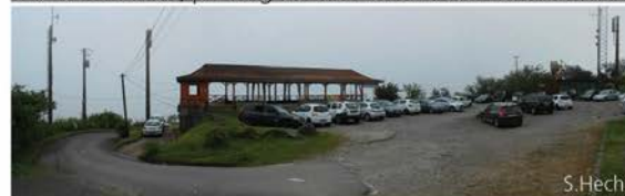
Site de l'Aïleron, parking et bâtiment du restaurant/snack.
