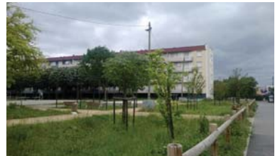
19 Friche de la première démolition 2015
