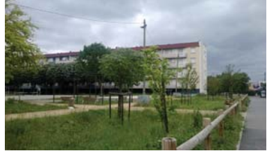
19 Friche de la première démolition 2015
