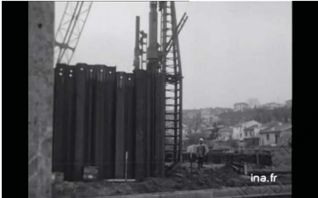
FIG.16 Installation des murs de soutènement, Rangueil
