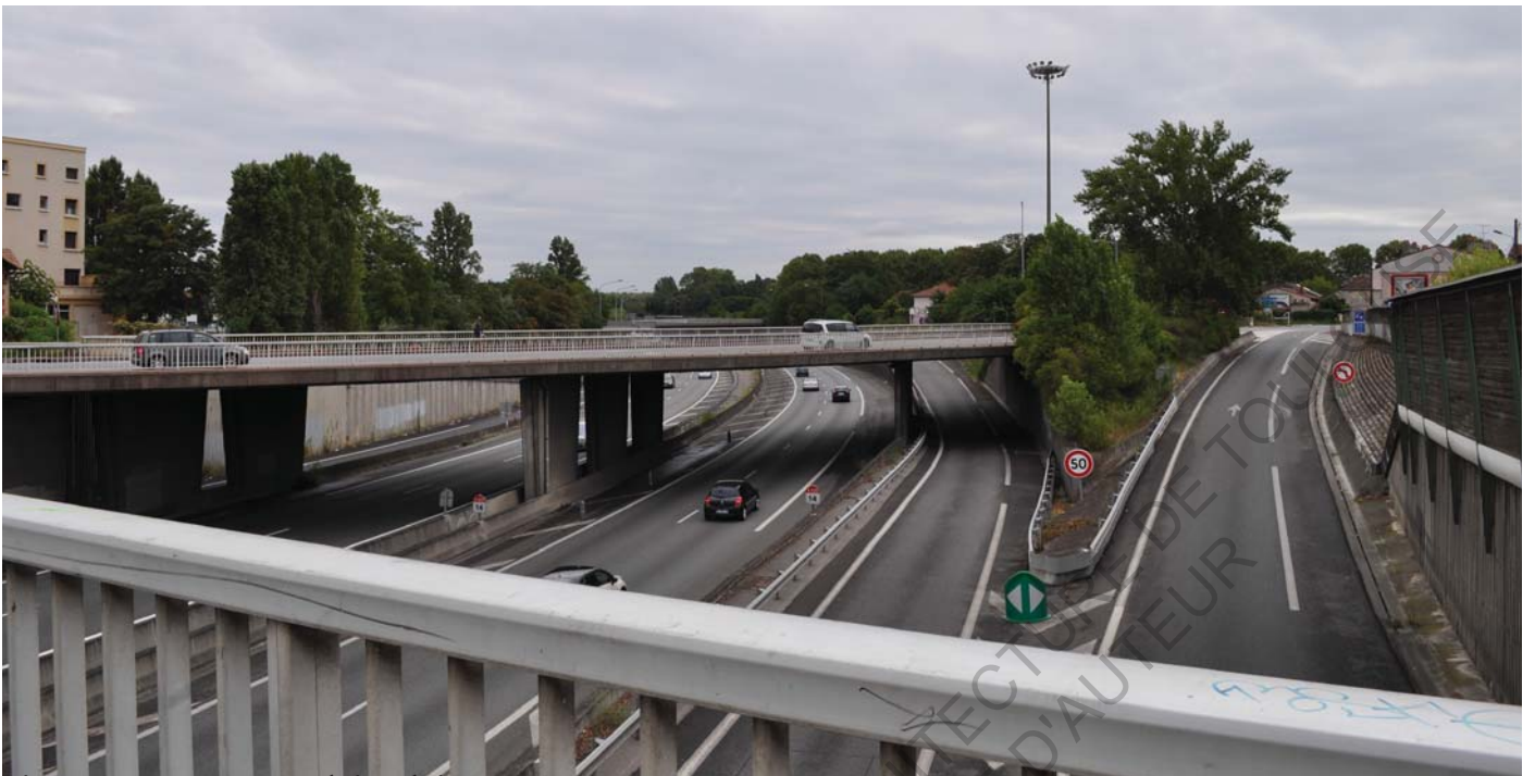
Fig.24 Vue sur le périphérique
