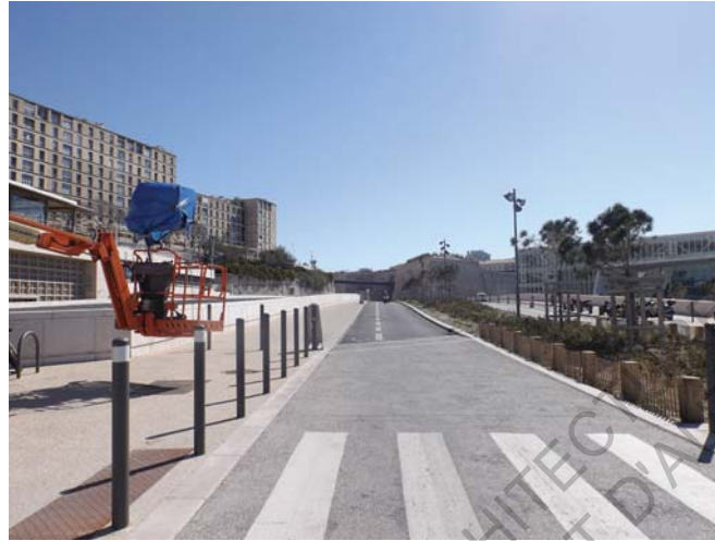
Fig 35. Vue vers le sud
