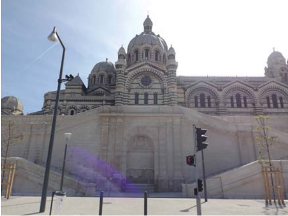
Fig 22. Escalier de la Major Photo personnelle
