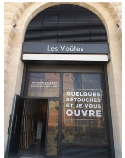
Exemple de magasins en travaux
