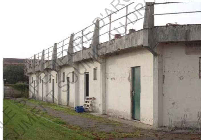
Figure 59 : Arrière des gradins, 2014
