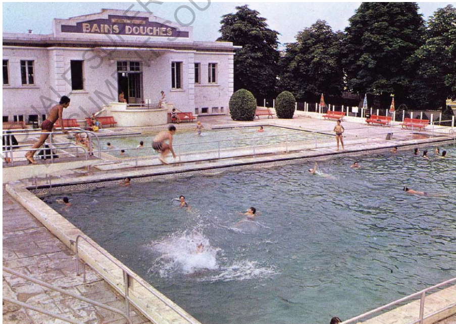
Figure 54 : Piscine après construction du second bassin Source : Document AVH
