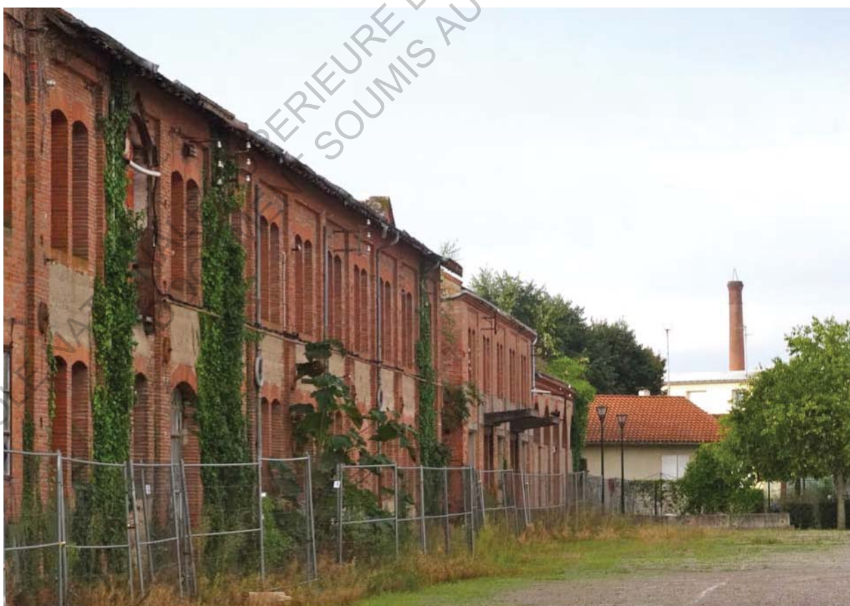
Différents corps de bâtis de l'usine Brusson, 2015
