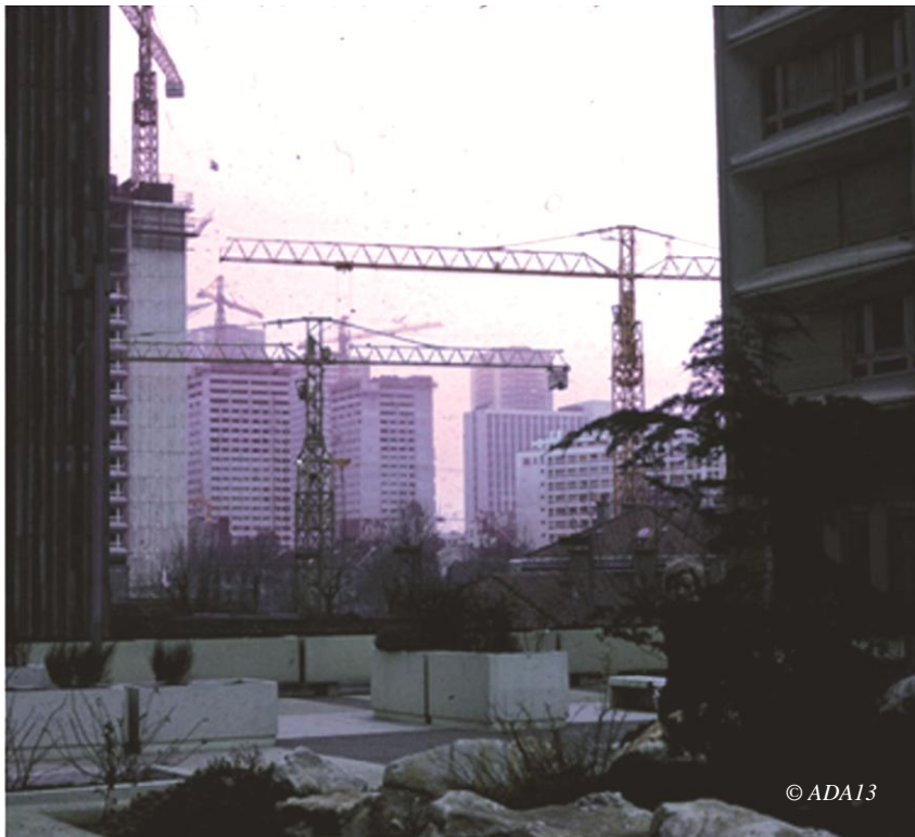
Photo7 : Photo prise sur la Dalle des Olympiades lors de sa construction. En arrière plan, les tours de l'avenue de Choisy en chantier, 1974.
