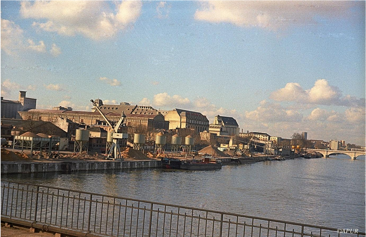
Photo 35 : Vue sur le Quai Panhard et Levassor depuis le pont National. (1973)
