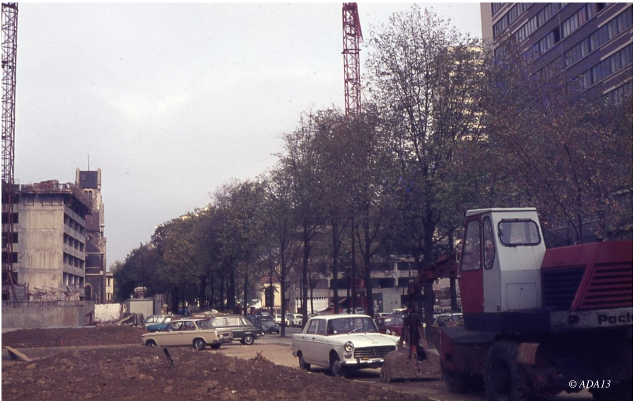
Photo 11 : Construction des Tours Verdi à la place des anciennes usines Panhard, avenue de Choisy.
