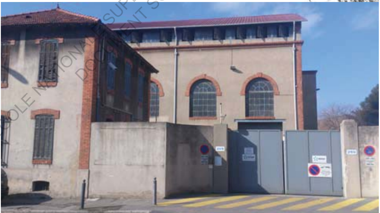
Ancienne usine à gaz - Appartenant maintenant à GDF Suez.
