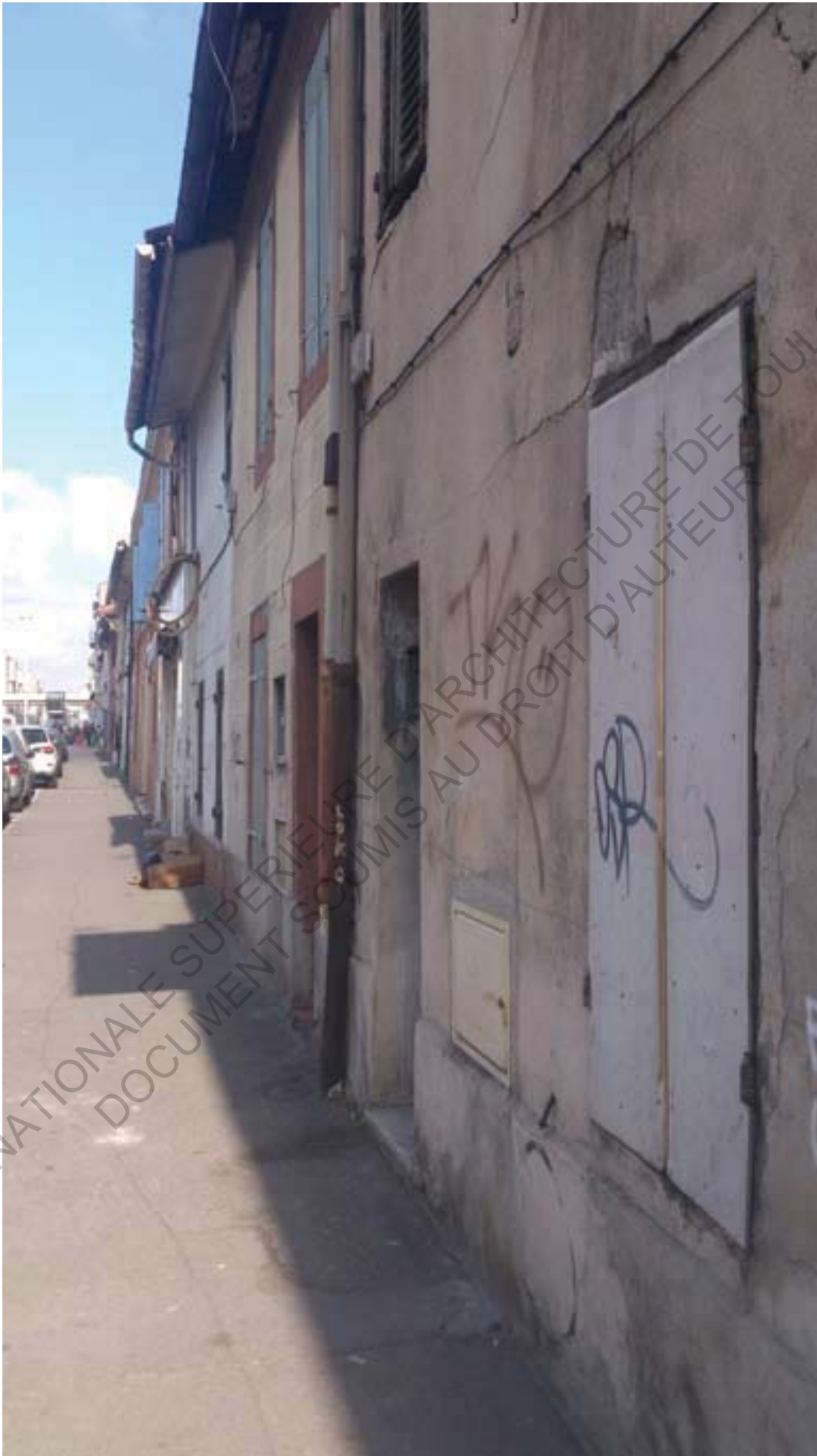
Immeubles vides et murés - Figure de la dégradation
