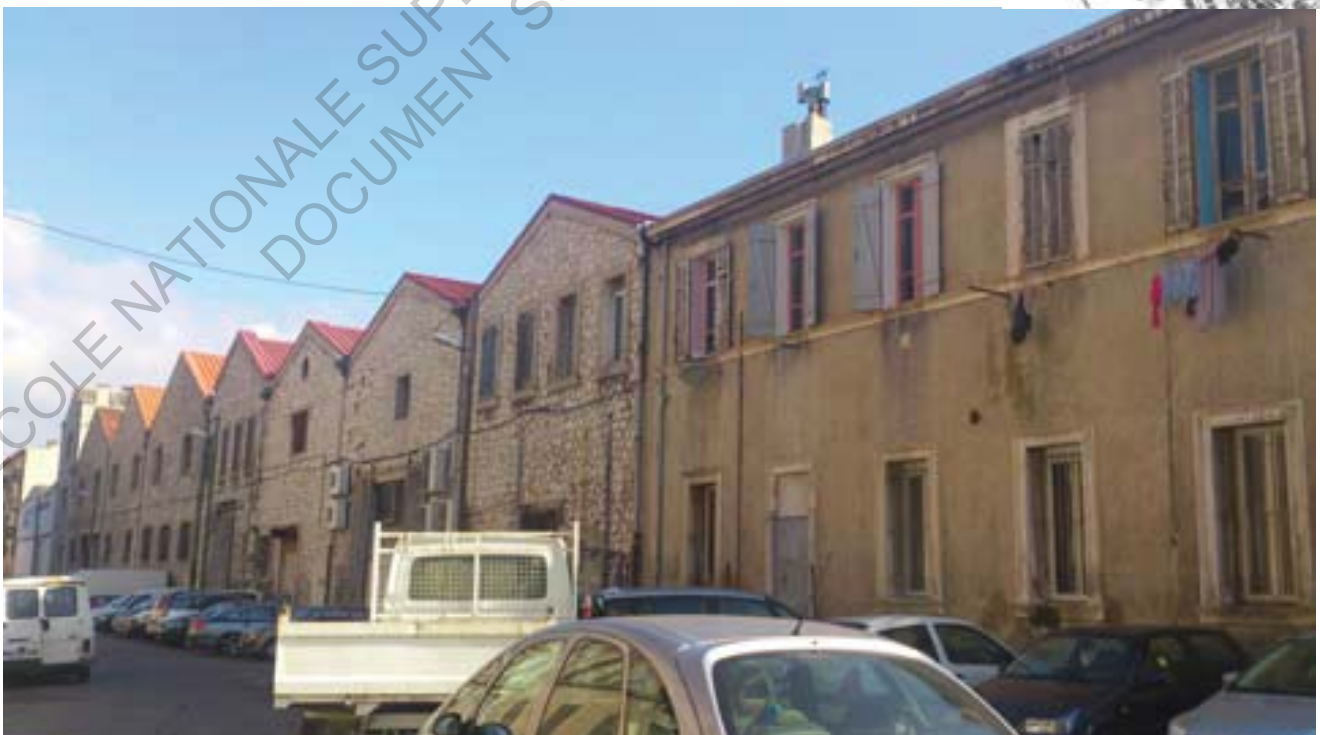
Un quartier marqué ntre typologie industrielle et immeubles marseillais
