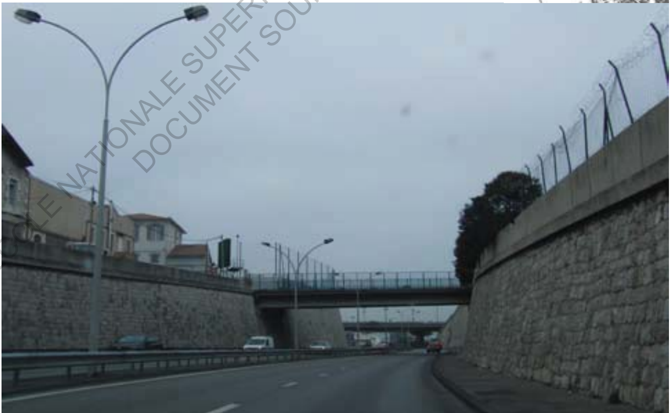
Infrastructure coupant le quartier - Boulevard Capitaine Oddo
