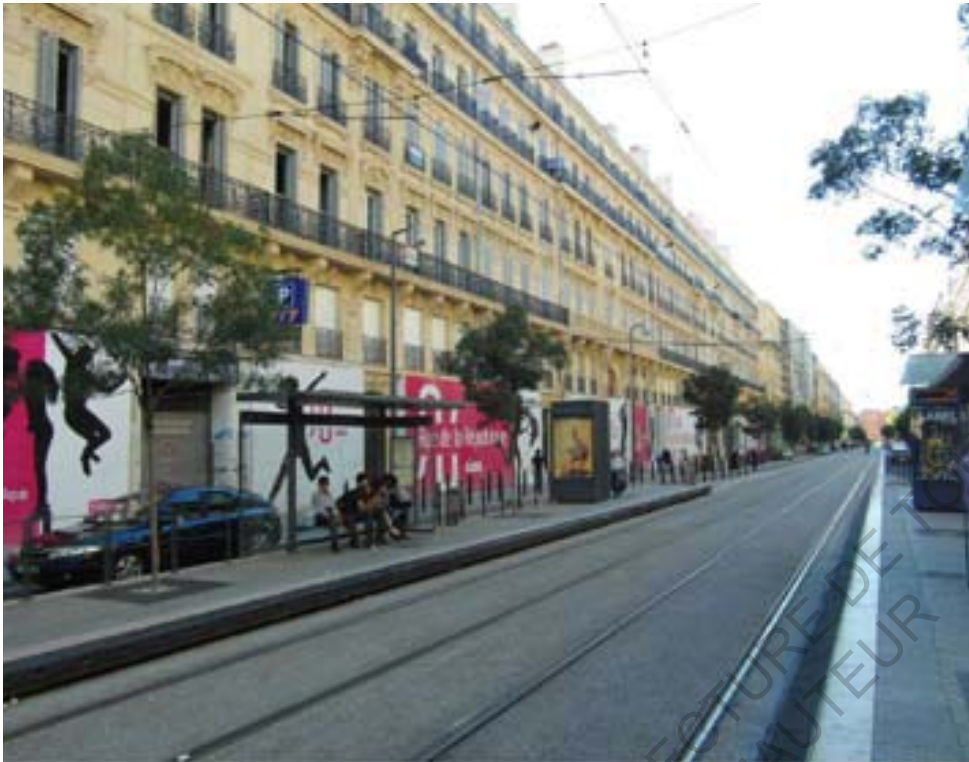
Rue de la République après rénovation
