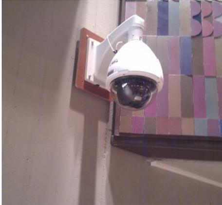
Illustration 16: Caméra de remplacement Elbex de type globe.
