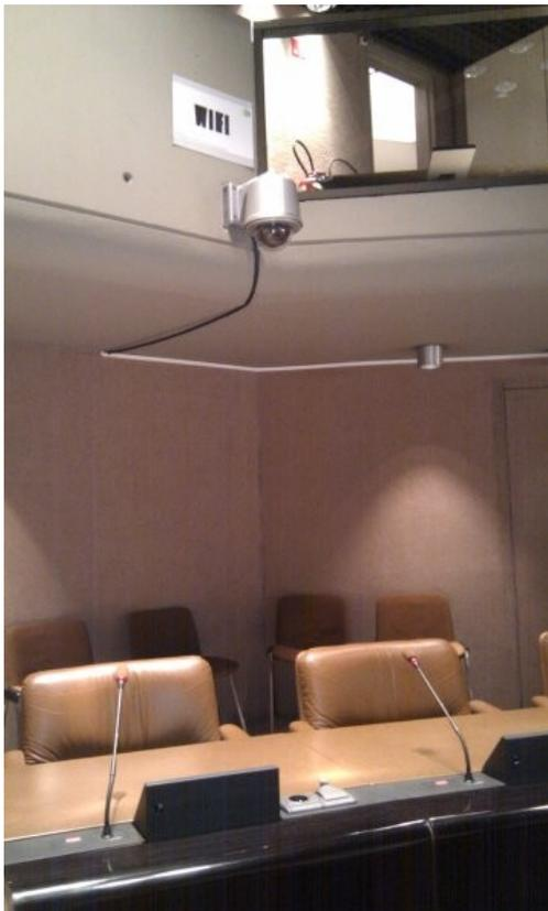
Illustration 17: Aperçu d'une nouvelle caméra Samsung à globe « discret » dans la salle du conseil.
