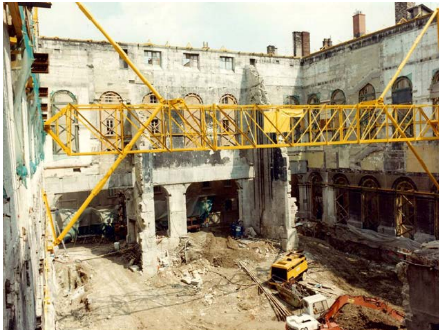
Figure n° 28 : Étalement volant utilisé pour la réfection de l'opéra de Lyon
