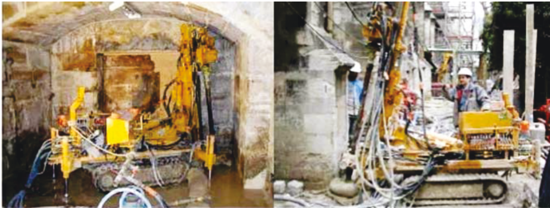
Figure n° 18 : Renforcement de fondation avec micropieux
