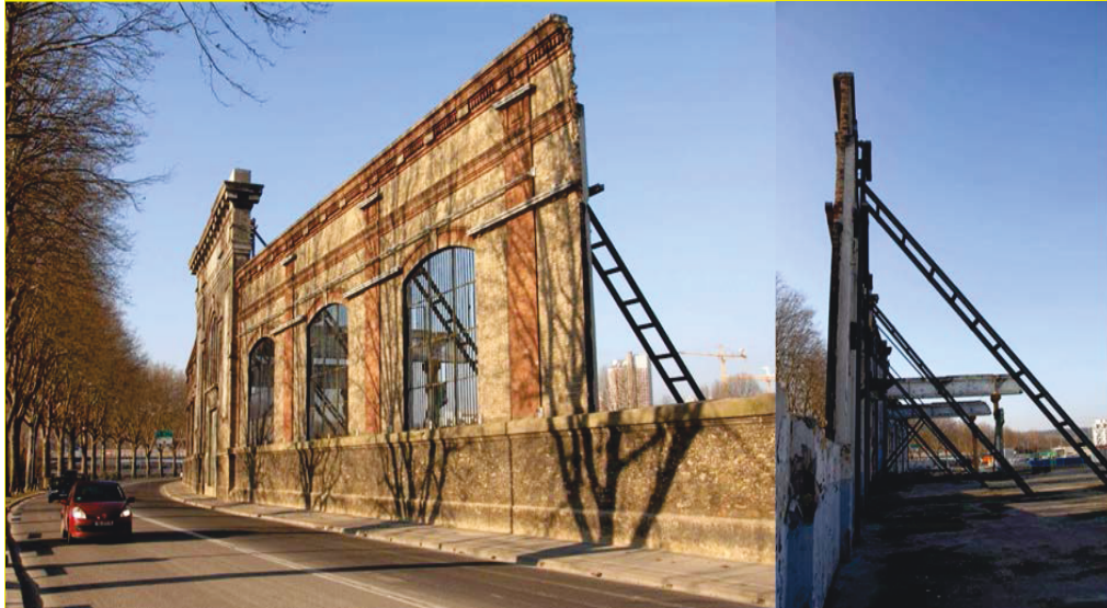
Figure n° 22 : Étaieiment interne d'une façade historique des usines Renault à Boulogne Billancourt
