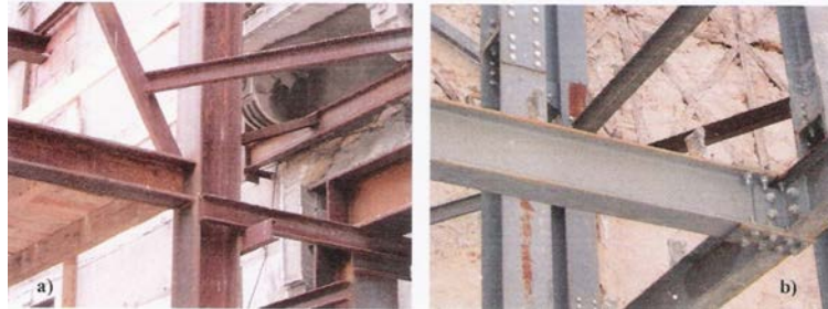
Figure n° 13 : Liaisons des structures a) soudées b) boulonnées
