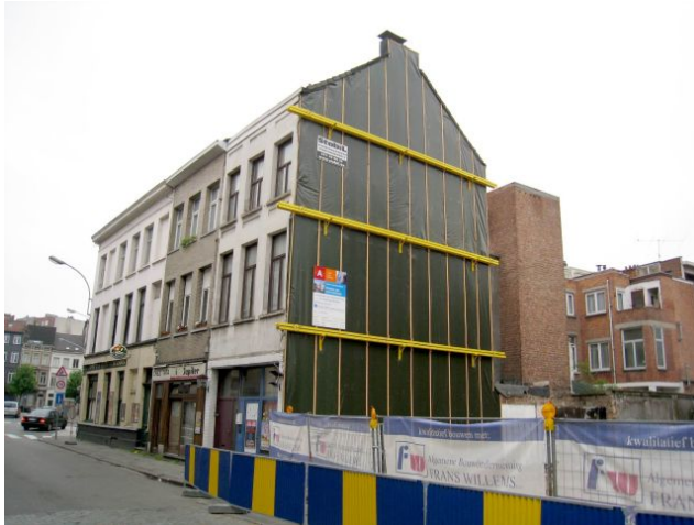
Figure n° 25 : Ancrages dans mur porteur, avec liaison poutrelles métalliques
