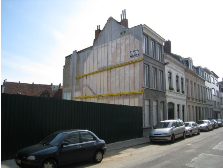
Figures n° 74 : Épinglage avec poutres
