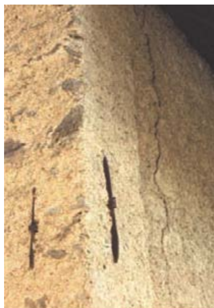
Figure n° 6 : Renforcement par tirants d'un bâtiment dans les Hautes Alpes
