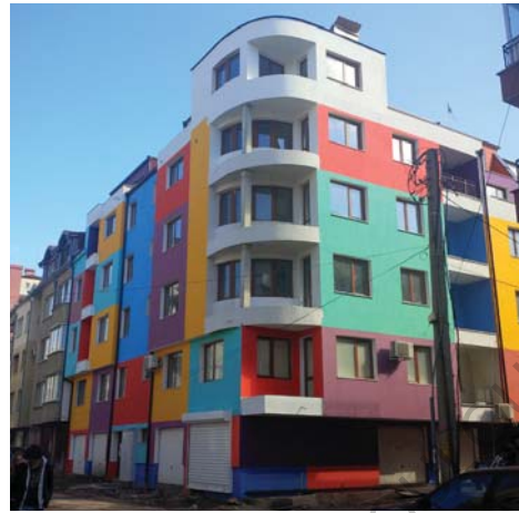
Figure 08 Photo d'un bâtiment coloré Séminaire Images de ville
