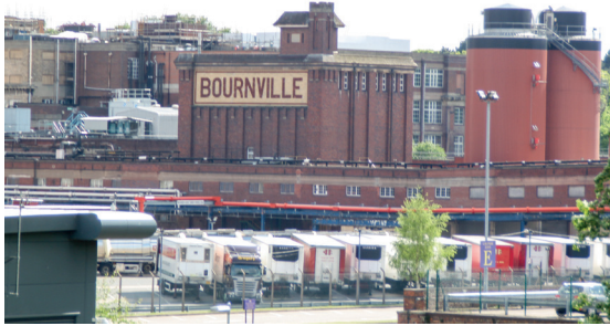
Photographie de l'usine de Bournville, 2012, R. Avril
