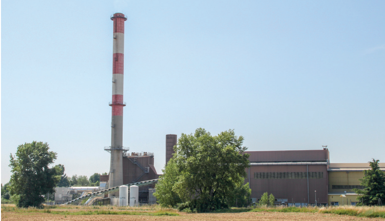
Photographie de l'entreprise Eurofloat, 2015, R. Avril
