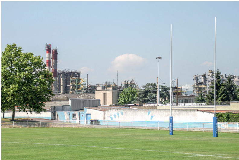
Photographie du stade du Rhodia Club, 2015, R. Avril
