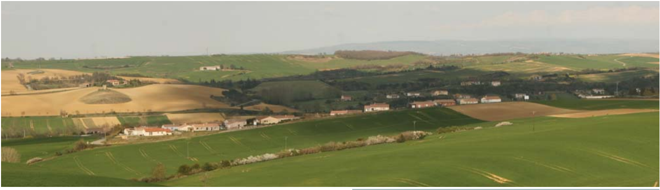
31 // Lotissement à Salles sur l'Hers, en pleine ligne de crête...
