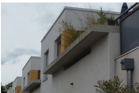
Figure 45. Photographie des tablettes «protège-vue» prolongeant les garde-corps de l'opération «Le Bellevue II», à Pont-de-l'Isère (26). Source : MAD
