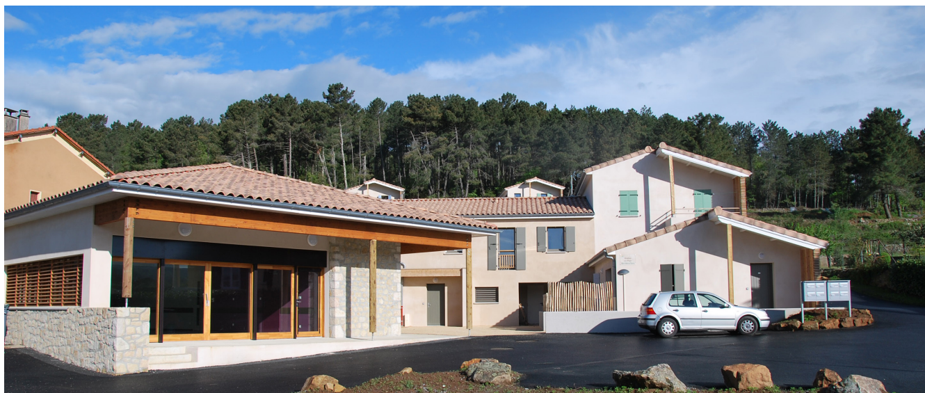
Figure 29. Photographie de la salle polyvalente prise depuis la place centrale du bourg. Opération «Les Bruges», à St Julien du Serre (07). Source : CAUE 07
