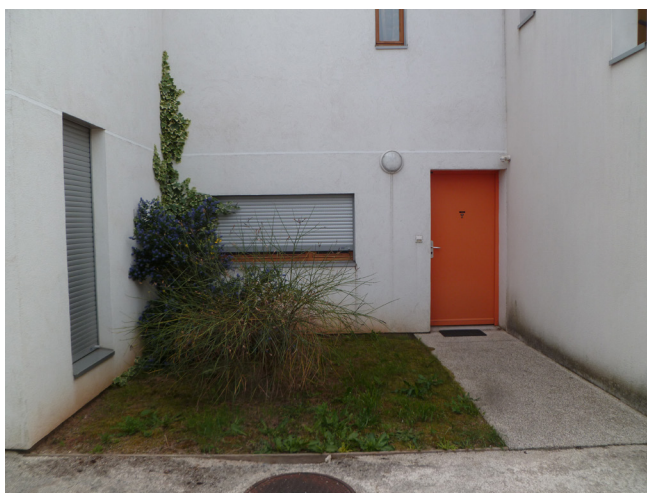
Figure 40. Photographie d'une entrée préservée par un espace de verdure en retrait. Opération «Le Bellevue II», à Pont-de-l'Isère (26) . Source : MAD
