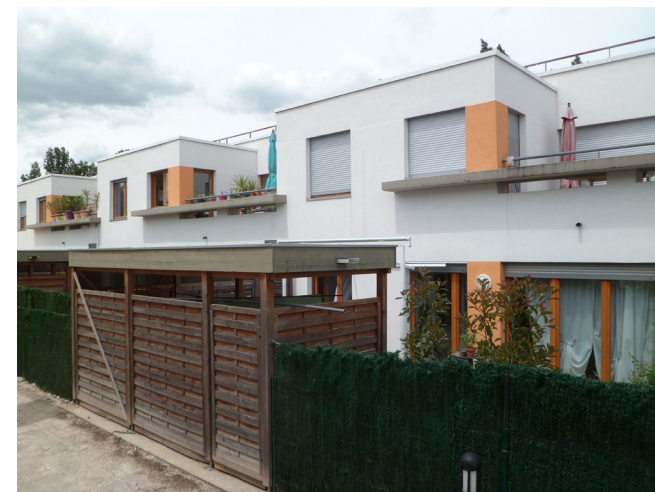
Figure 47. Photographie d'un auvent de jardin servant également de barrière visuelle, opération «Le Bellevue II», à Pont-de-l'Isère (26). Source : MAD
