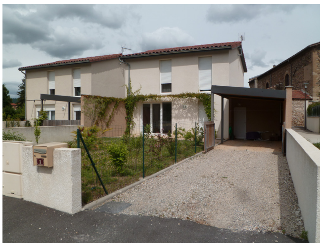
Figure 38. Photographie de l'entrée principale de la maison, qui se fait par un portillon dans le le jardin. Opération «Les Platanes», à Beausemblant (26) . Source : MAD
