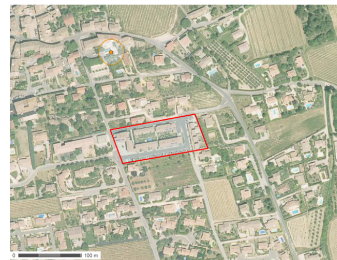
Figure 29. Vue aérienne de l'opération «Les Vignes» à Vinsobres (26). Source : www.geoportail.gouv.fr
