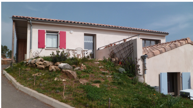
Figure 46. Photographie des niveaux de l'opération «Les Bruges» (07), où chaque logement est implanté sur un niveau topographique. Source : MAD
