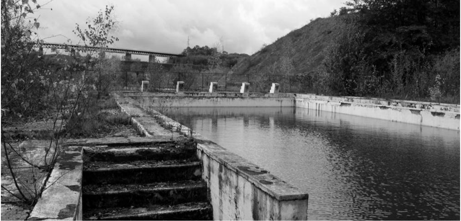
Piscine désaffectée sur le site des Terres Rouges, Luxembourg © Marion Chevallier, 2014
