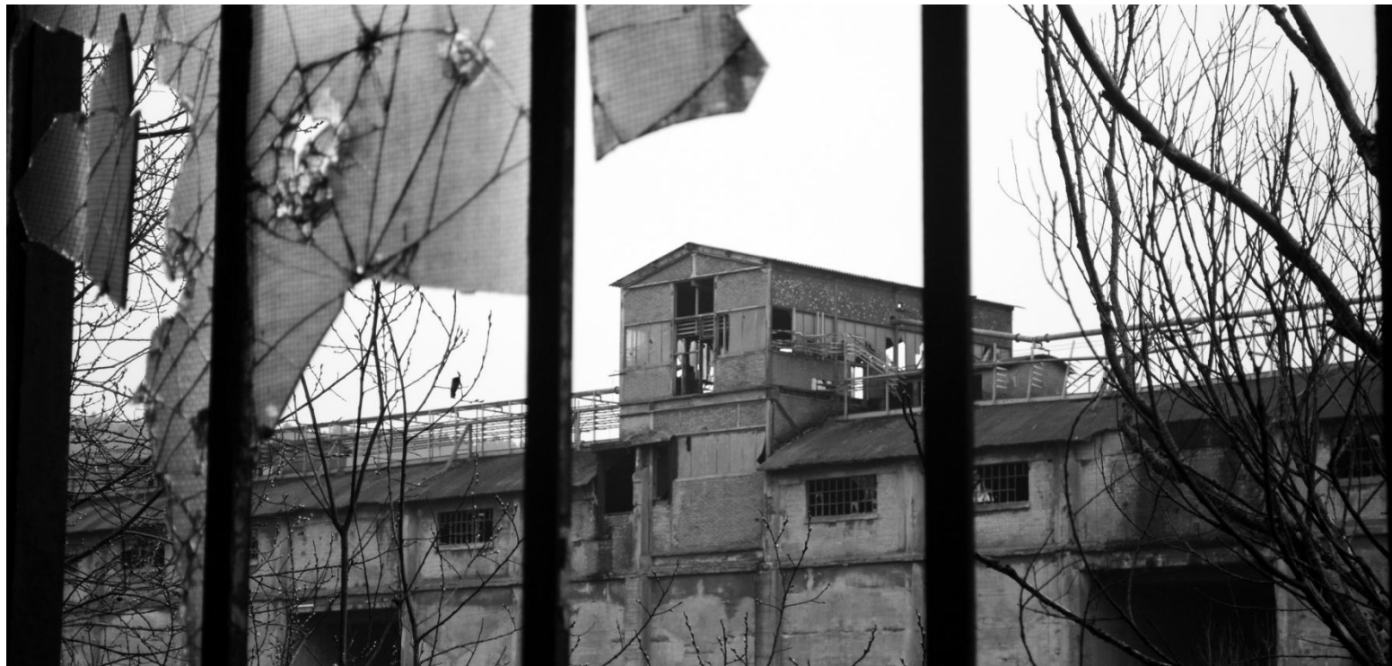
Friche industrielle des Terres Rouges, Luxembourg. © Marion Chevallier, 2015
