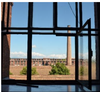
Figure 55. Réhabilitation du quartier DMC de Mulhouse, IBA de Bâle En 2008, la Société d'Équipement de la Région mulhousienne a racheté pour le compte de la Communauté d'agglomération 10 hectares de la friche de l'usine DMC pour en faire un nouveau quartier métropolitain aux fonctions mixtes. Des logements, bureaux, parcs urbains, et commerces sont prévus avec le soutien de l'IBA.
