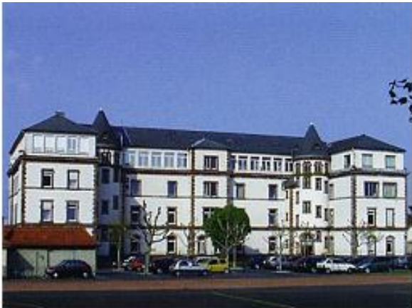
Figure 15 : Bâtiment principal du site de Saverne
