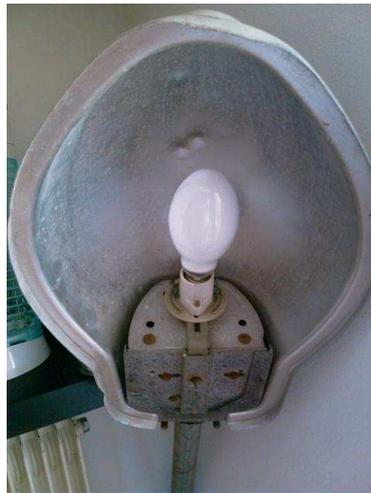
*Figure 21 : luminaire avec une lampe à vapeur de mercure*
