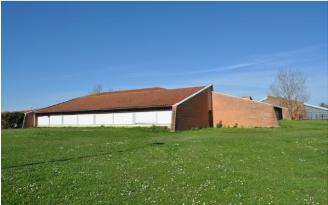
Photographie de la façade arrière de l'internat du lycée Charles de Gaulle
