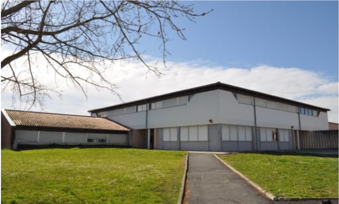
Photographie de la façade avant de l'internat du Lycée Charles de Gaulle
