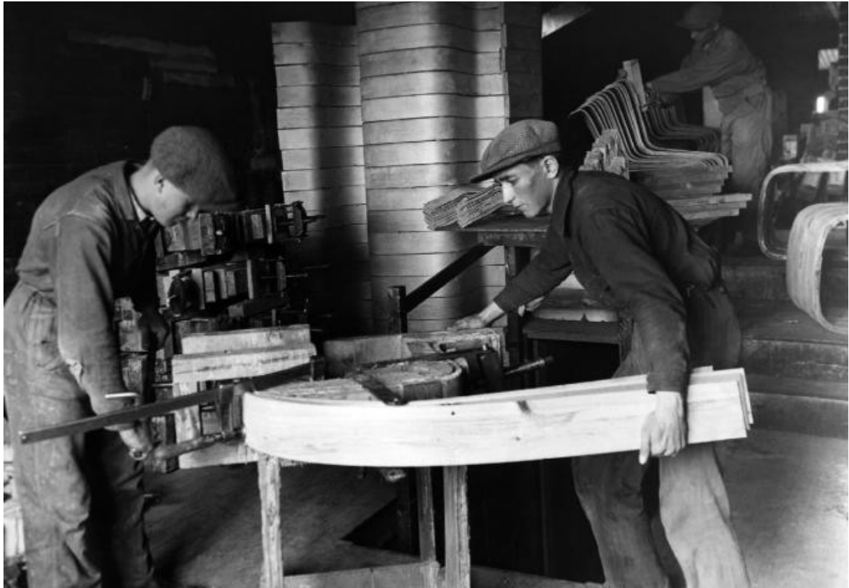
Manufacture Artek, technique du bois lamellé courbé.
