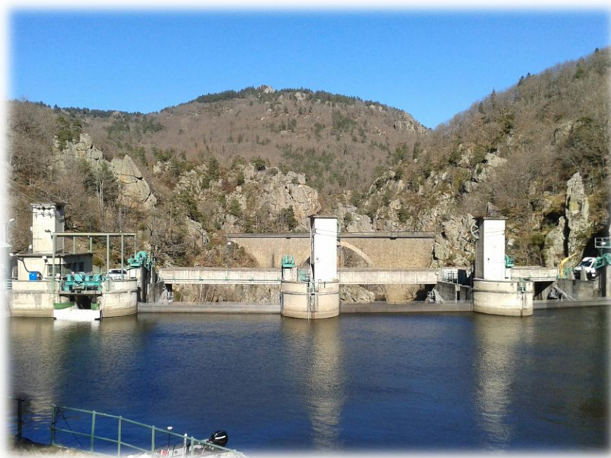
Barrage de Poutès, Mars 2015, Marine Lemaire
