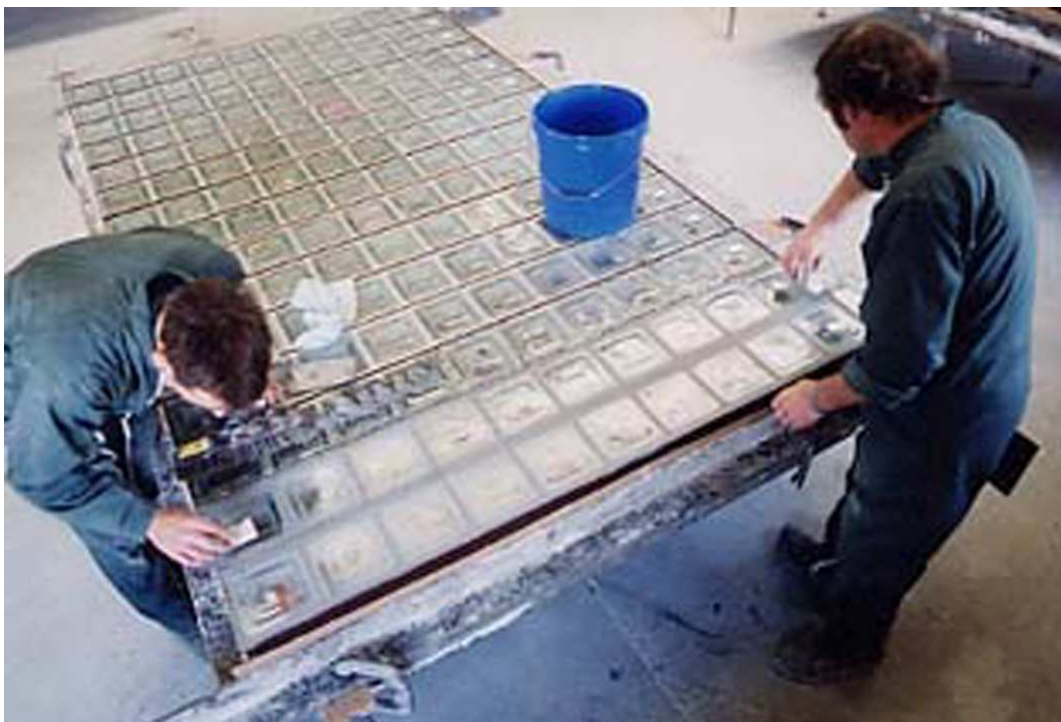
Figure 11 : Usine de préfabrication SAVERBAT à Grandvilliers (60).
