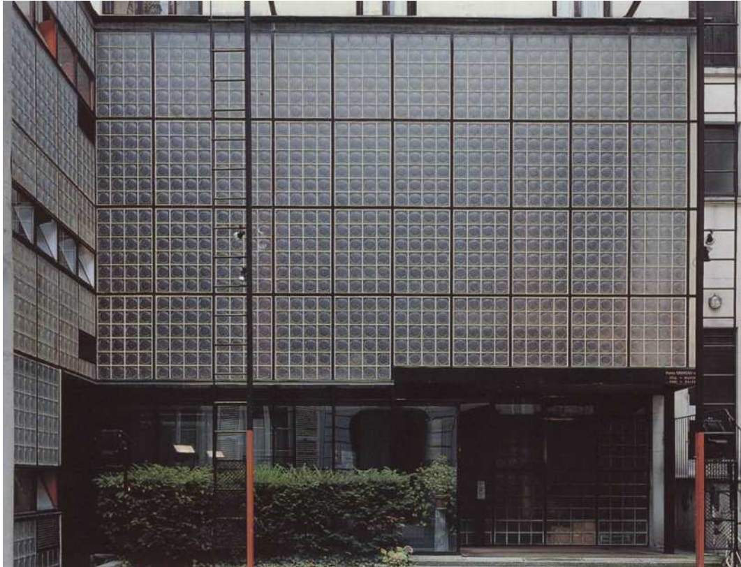
Figure 14: La maison de verre de Pierre Chareau, façade sur cour.
