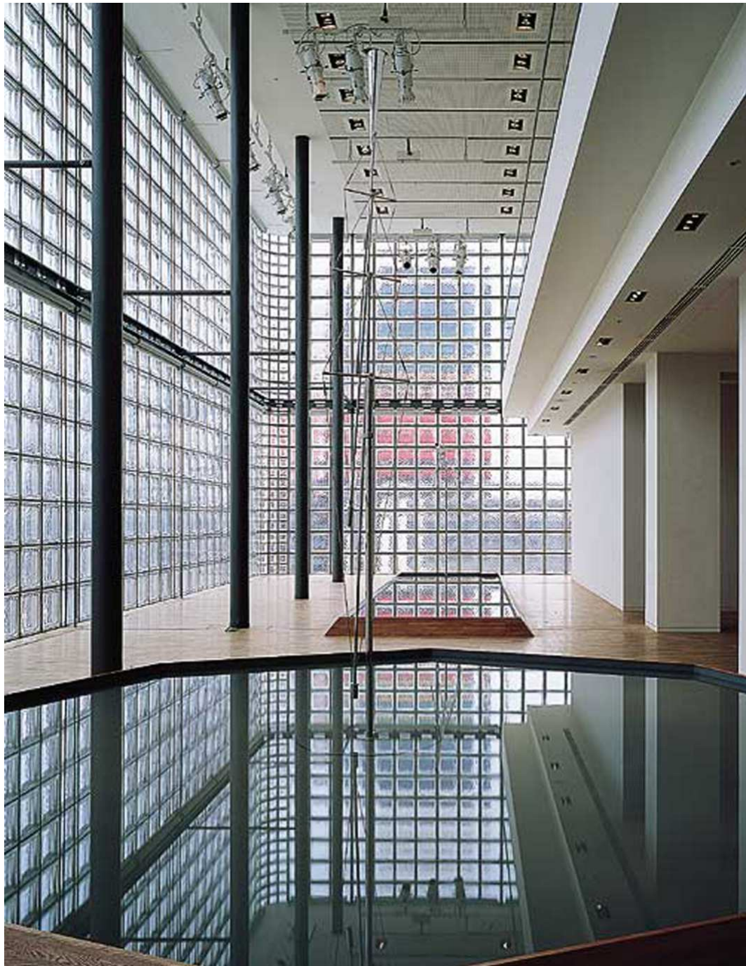
Figure 13: La structure métallique d'une élasticité multidirectionnelle répondant aux contraintes parasismique et celle fixant le voile de verre sont quasiment autonomes.
