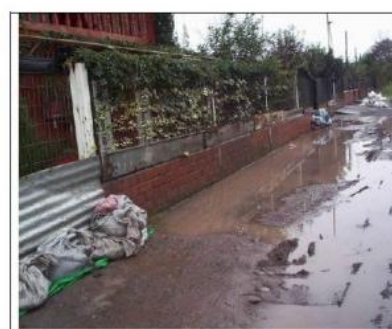
FIGURA 2.15 CALLE LOS INGLESES, DESCARGA QUEBRADA LA ÑIPA
