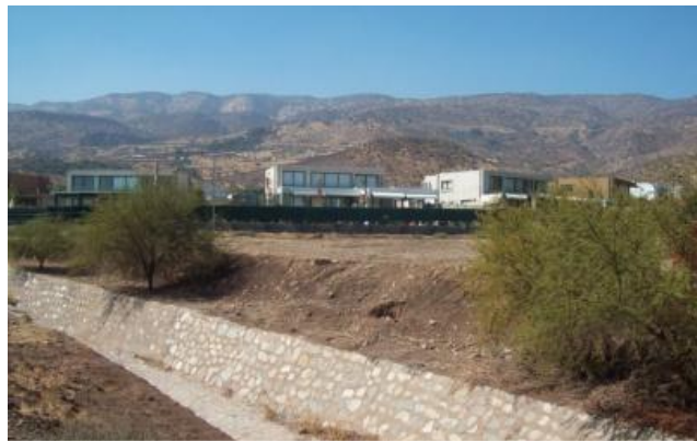
Image 42: Torrent le Manzano canalisé en traversant l'ensemble de la ZODUC de Piedra Roja. Crédit Chloé N-A
