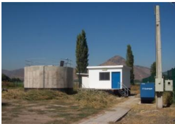
Image 36: Puits Aguas Manquehue. Crédit: Chloé N-A
