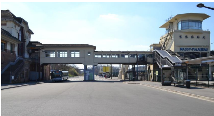
Figure 15 Côté Est : ancien bâtiment voyageur et ancienne passerelle, toujours accessibles
