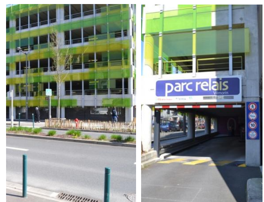
Figure 16 Côté Ouest : le parking relais Vilmorin et sa capacité de 400 places couvertes
