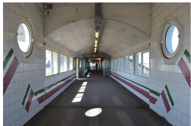
Figure 21 L'ancienne passerelle ne pouvait plus supporter une capacité de plus de 50 000 voyageurs journaliers à elle seule
