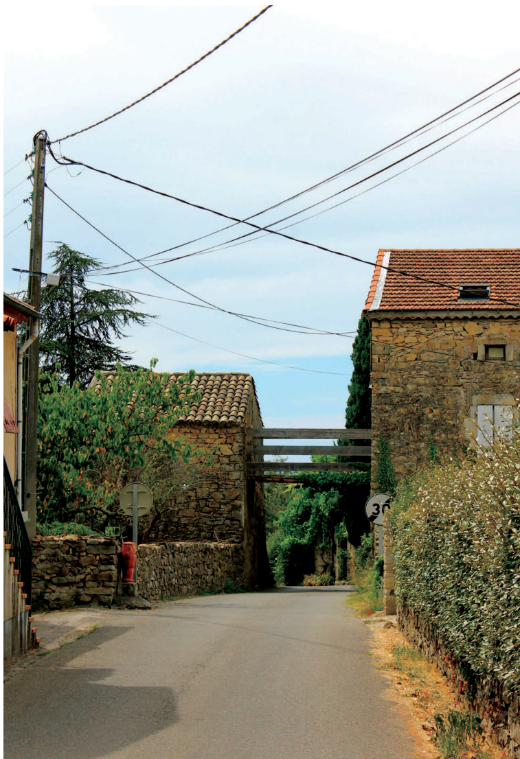
Murets en pierres sèches en continuité du front bâti des hameaux
