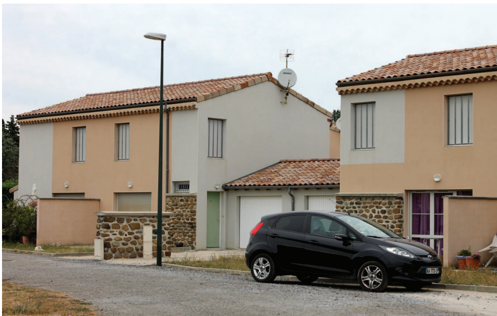
La conception architecturale, reprenant quelques éléments d'architecture locale (volumes simples, utilisation de pierres apparentes en calcaire et basalte sur certains pans de murs, génoises) permet d'inscrire le projet dans la continuité du centre ancien. La mitoyenneté entre les logements se fait par le garage, garantissant une certaine indépendance des habitations et une bonne isolation phonique
