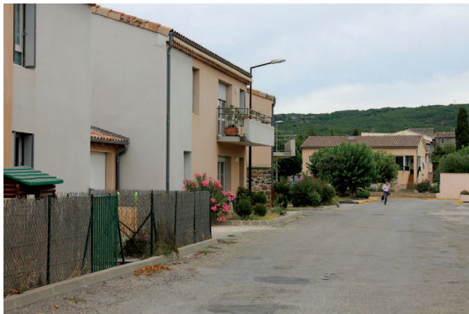
Le bâti, organisé en front autour de l'espace public, confère un caractère urbain au site et rappelle l'organisation du centre ancien situé à proximité immédiate.
