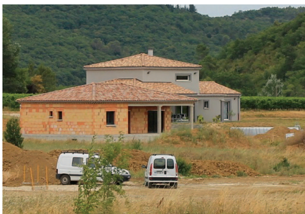
Construction neuve en 4 volumes
