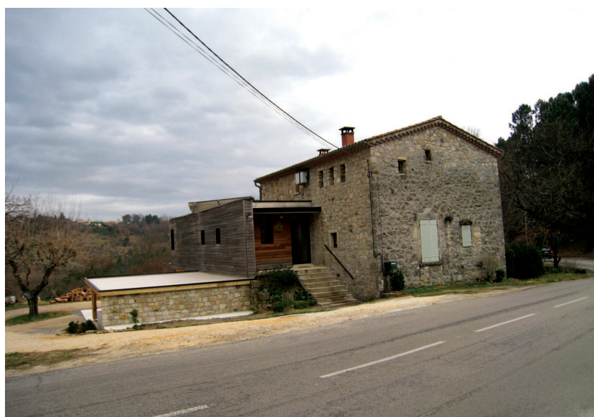
Exemple de rénovation
