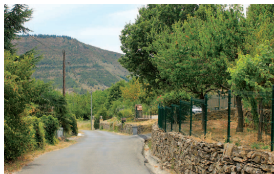
Murets conservés et rénovés en limites parcellaires de maisons individuelles récemment construites
