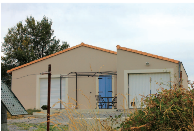
L'article 11 impose que «l'égoût de toiture du bâtiment principal possède une génoise à simple ou double rangée», ce qui n'est pas le cas de ce pavillon.
