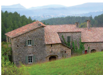
Toit en tuiles mécaniques dans les Boutières
