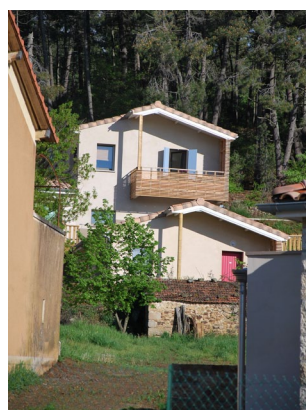
Exemple de construction contemporaine : le bâtiment répond à de nouvelles attentes et besoins tout en s'insérant dans son environnement
