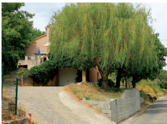
Mur en parpaing, rompant le linéaire créé par les murs en pierres sèches
