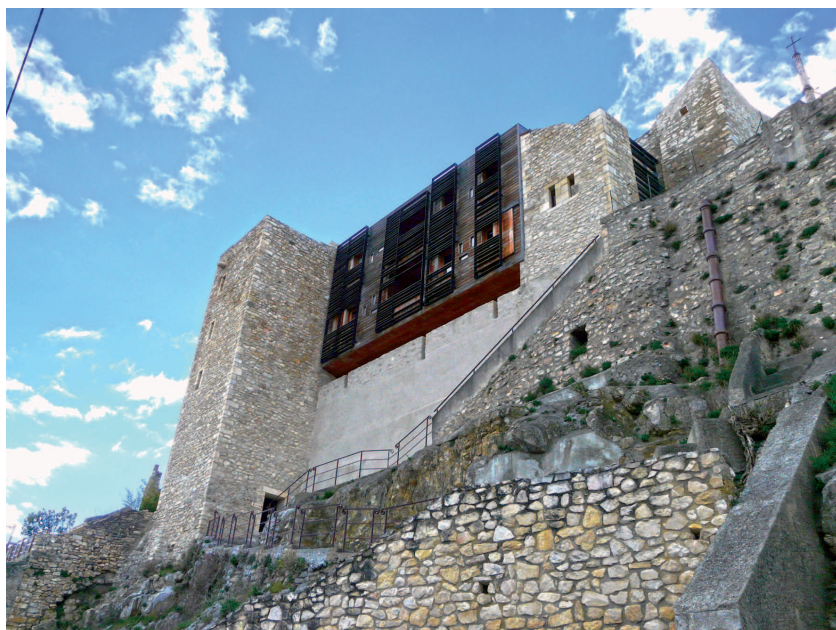
Exemple de rénovation à Cruas, dans la vallée du Rhône
