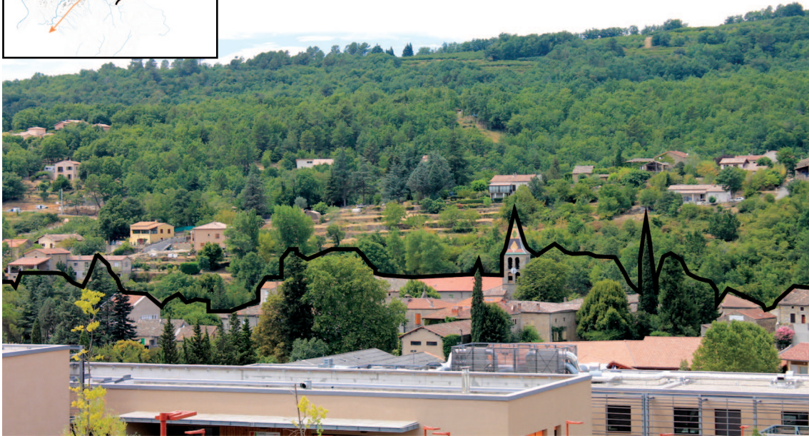
Vue vers l'Ouest sur le centre bourg en premier plan, dont on distingue le clocher de l'église, et la zone Ub de Cournarède depuis le versant Est du territoire communal. On observe ainsi le mitage du coteau, à proximité immédiate du centre bourg
