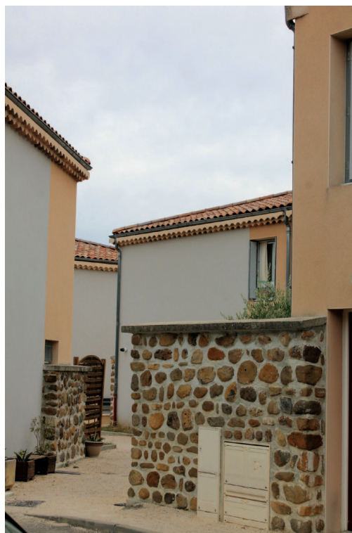
Le quartier est organisé autour de cheminements piétons qui le relie aux équipements publics de proximité et au centre ancien. De fait certains logements sont accessibles en voiture par l'entrée principale, d'autres par l'arrière du logement alors que d'autres ne sont pas accessibles directement.
