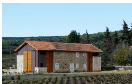
Exemple de rénovation
