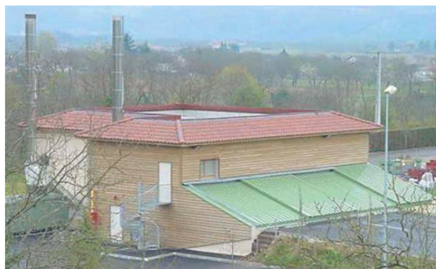
Figure 61 : Installation de chaudière collective bois énergie sur le territoire
