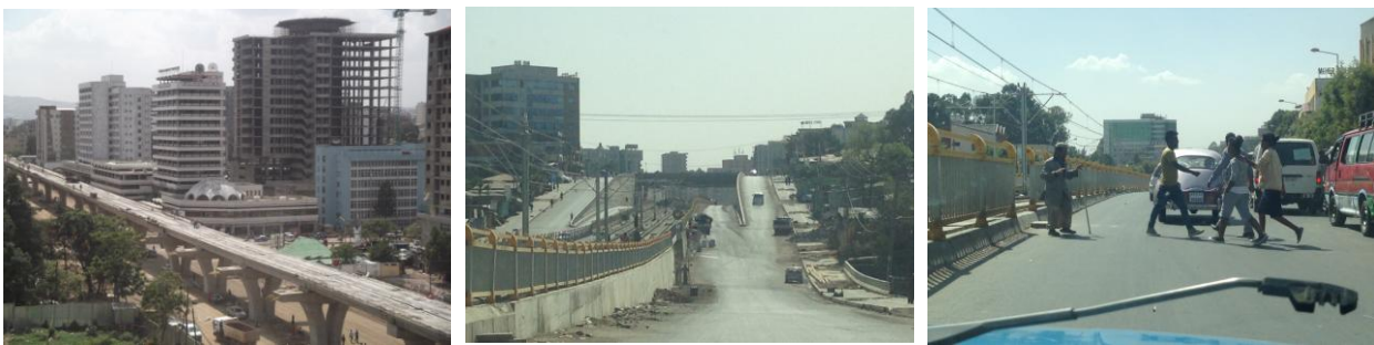
Figure 71 Les travaux du LRT;
