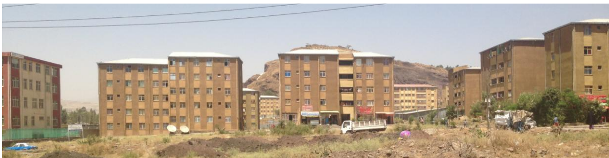
Figure 23 Condominiums de Gelan, au sud d'Addis-Abeba Source : Ratongaranto
