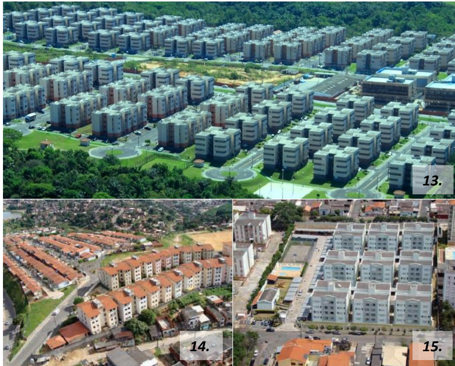
Figures 13, 14, 15 Exemples de condomínios populares présents au sein de villes appartenant à diverses régions du Brésil, 13: Manaus (Nord), 14: Bahia (Nord-Est), 15: Campinas (Sud-Est).
