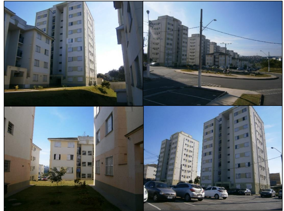
Figure 92 Photographies prises à l'intérieur du condominium Boulevard Residencial Club.
