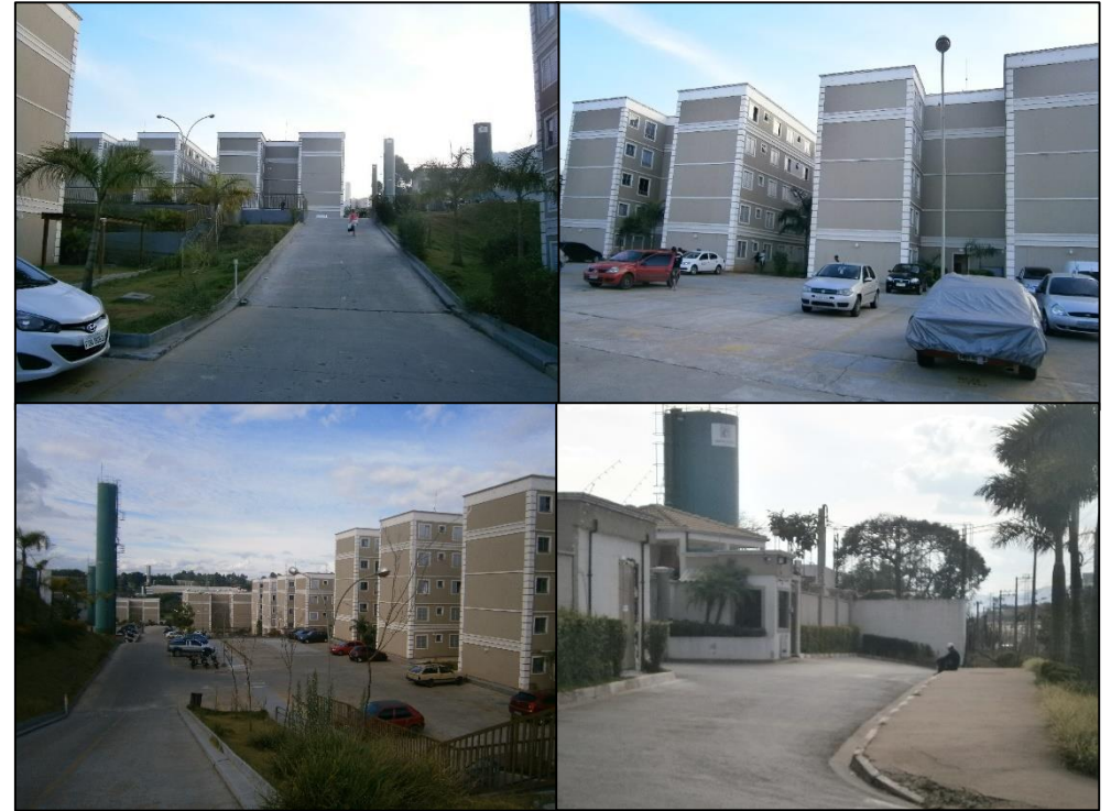
Figure 89 Photographies prises à l'intérieur du condomínio Parque Santa Cecília.
