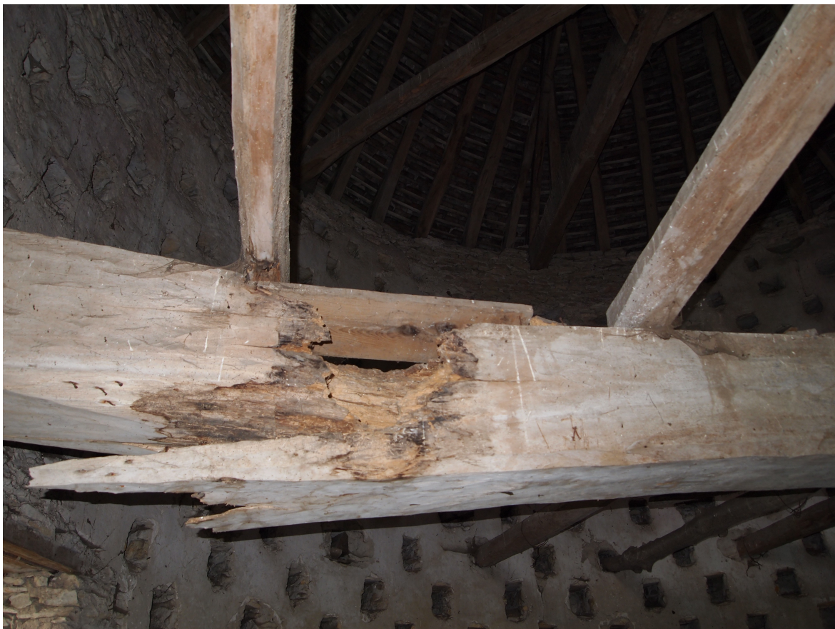
Partie d'échelle réutilisée dans la structure d'une mezzanine pour le foin (crédit de l'auteur)
