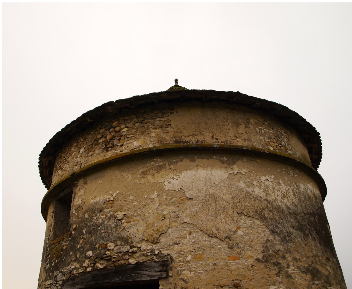
Corniche. Avec l'enduit elle empêche l'accès des rongeurs. Colombier de Quirieu au lieu-dit « Bayard ». Crédit de l'auteur.
