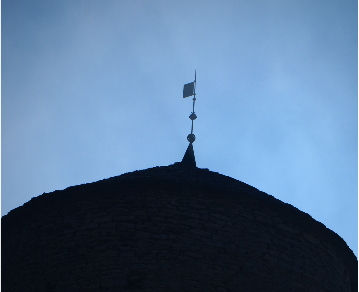
pigeonnier de Bouvesse (Bouvesse Quirieu)- Photographie de l'auteur
