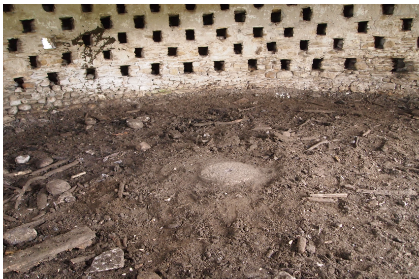
Ill.8 - Boulins et embase d'échelle du pigeonnier du Bayard (Quirieu)
