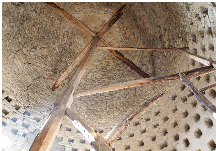
III.9 - Mécanisme de l'échelle tournante du colombier de Bouvesse sous son toit de lauzes
