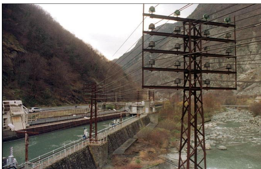
Figure 4 : Installations Hydro-électrique dans la vallée de la Romanche 16
