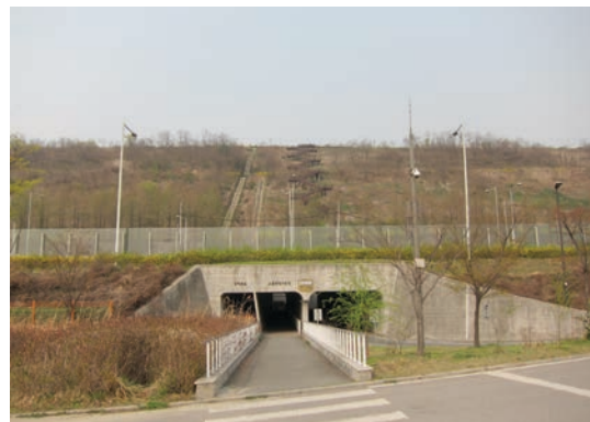
Figure 51. Photo du tunnel des trois passages, 2014, trois passages pour les animaux, les hommes et la voiture qui lie le parc du soleil couchant.
