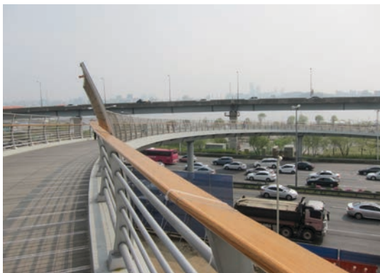
Figure 50. Photo depuis la passerelle piétonne, 2014, cette passerelle lie le parc de la paix et le parc des berges.
