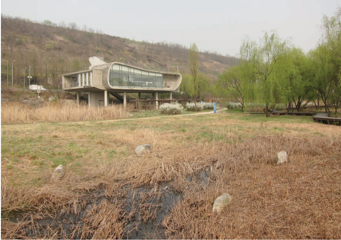
Figure31. Photo du centre d'étude, 2014, Le centre d'étude se situe au dessus de la zone écologique pour gérer et enrichir la biodiversité de la zone.
