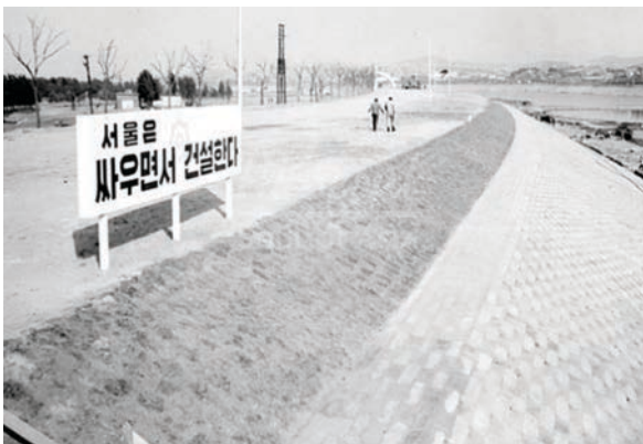
Figure 86. Photo de l'île de Yeoui, 1968, sur le panneau de la photo est écrit 'Séoul construit en battant', on parle de la construction des digues en 100 jours
