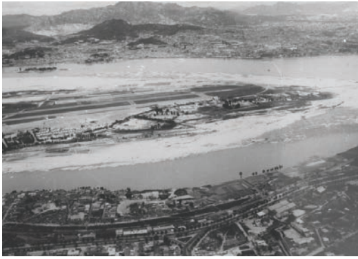
Figure 84. Photo de l'île de Yeoui, sd, avant la construction des digues, l'enrochement des sables était présent.
