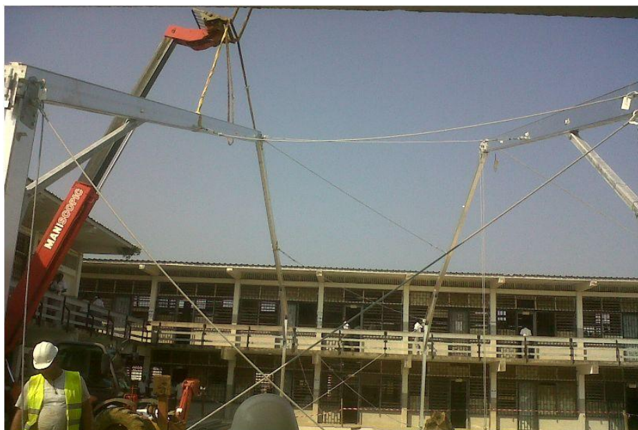
Image 42 : Ossatures en cours de levage
