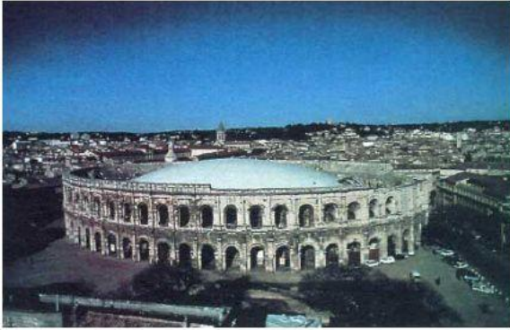
Image 2 : couverture en lentilles d'une arène de Nîmes
