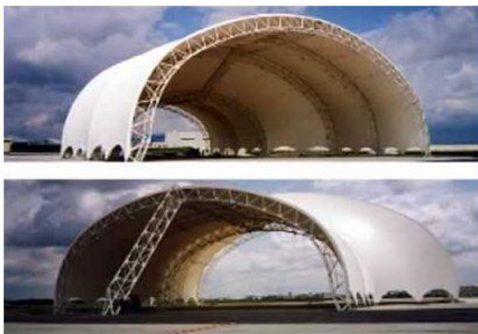
Image 11 : Exemple d'ossature support de toiles tendues
