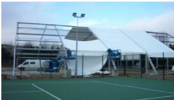
Image 32 : Entoilage en cours sur un prostock ®
