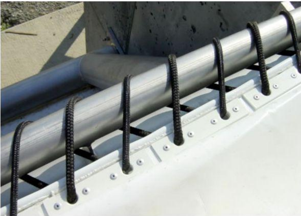
Image 13 : Exemple de liaison toile – ossature par laçage
