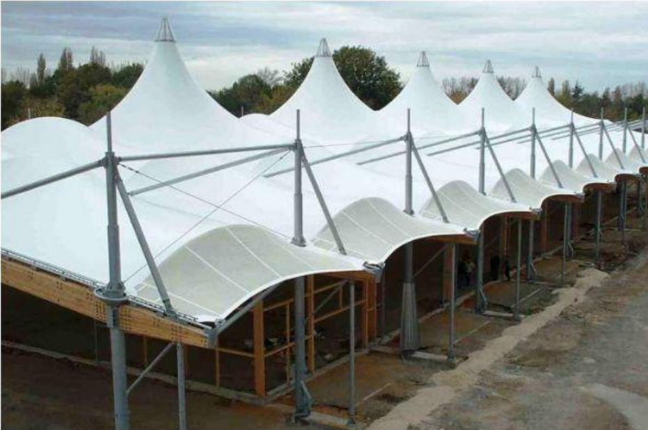
Image 15 : Exemple de prétension ponctuelle dit de type « Chapeau chinois »
