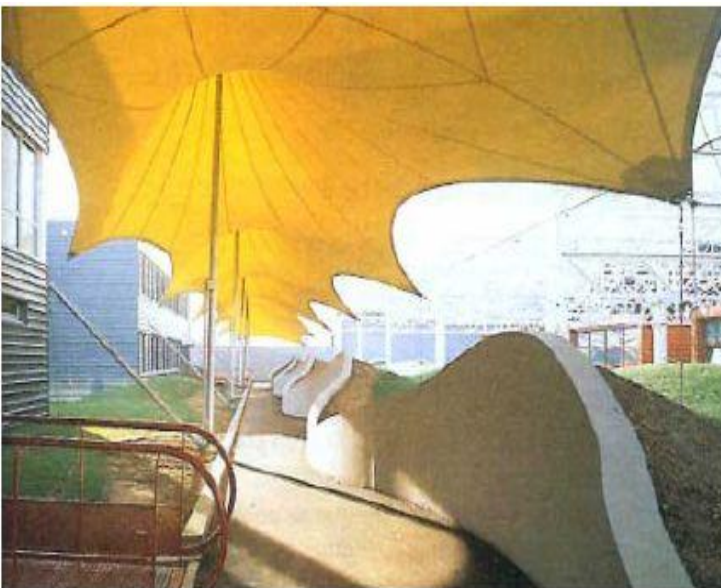
Image 4 : Structure à prétension ponctuelle
