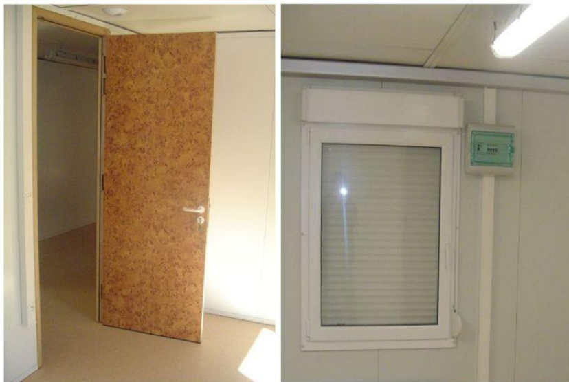
Image 38 : Aspect final de l'intérieur des enceintes destinées à accueillir des bureaux.
