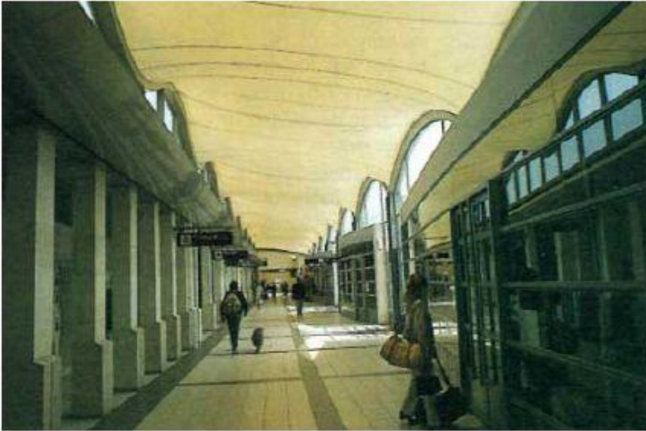
Image 3 : Structure à prétension linéaire – Extension de la gare TGV à Poitiers
