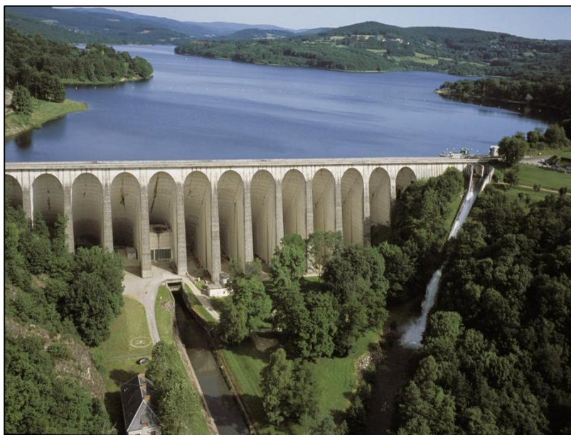
Annexe 2: Photographie du barrage de Pannecièrre (Source : EPTB Seine Grands Lacs)
