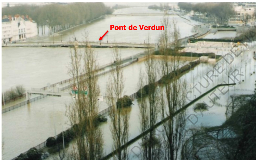
Figure 19 : crue de la Maine dans la traversée d'Angers en 1995 (pont de Verdun quasi submergé). Source : SCE [112]
