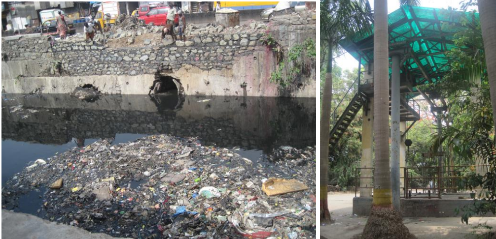
A Gauche. Collecteur principal sur 60 Feet Rd. A Droite Pumping House Dharavi
