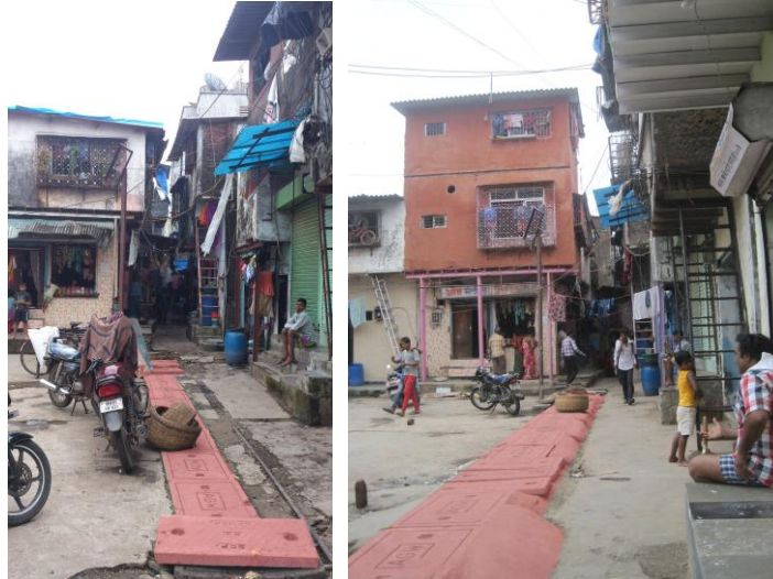
Deux photos du même secteur à Dharavi qui ont été pris en août de 2013 et Juin 2014, des photos montrent en rouge le modification du système de drainage.
