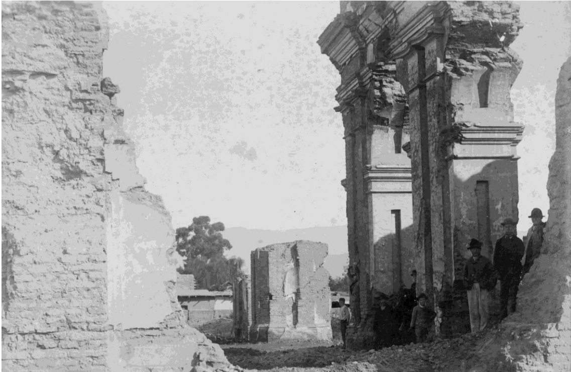
Figure 7. Église de San Francisco (Mendoza) après le tremblement de terre de 1861. (Source : INPRES, 2015)
