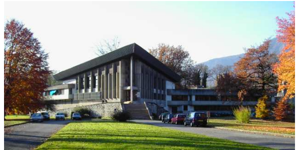
Figure 1 : Bâtiment de l'IRSTEA Grenoble
