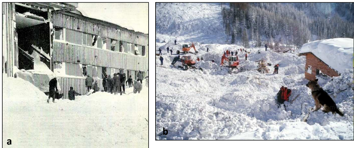
Figure 4. Destruction des locaux de l'Union Nationale des Centres sportifs de Plein Air par l'avalanche de Val d'Isère en 1970 (a) (source : http://lvb.avalanche.free.fr/ ) et Chalets détruits après l'avalanche de Montroc en 1999 (source : Dauphiné Libéré).
