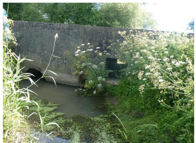
Figure 2 Exemple de passage à faune double (terrestre et aquatique) ©Dallongeville Odeline
