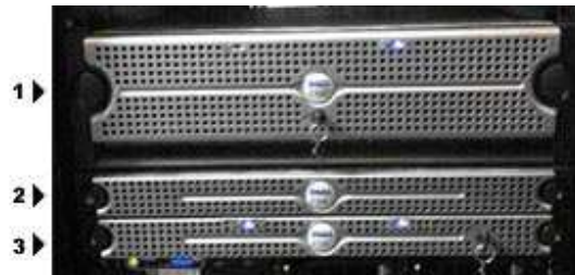
Détail des éléments de la baie: zoom (photo: P.Caujolle)
