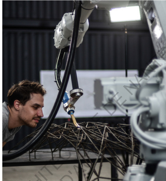
Projet MX3D, construction d'une passerelle imprimé en acier à Amsterdam en utilisant deux bras robotiques.
