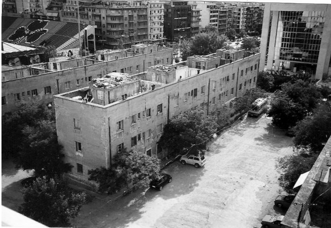
Immeubles de travailleurs réfugiés Alexandras Av. Athenes, Grèce Document : Syndicat des architectes de Grèce
