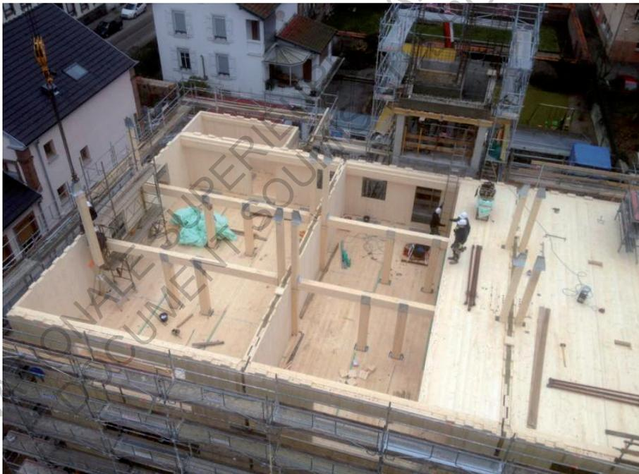
Vue des panneaux CLT et du système poteaux poutres lors du chantier
