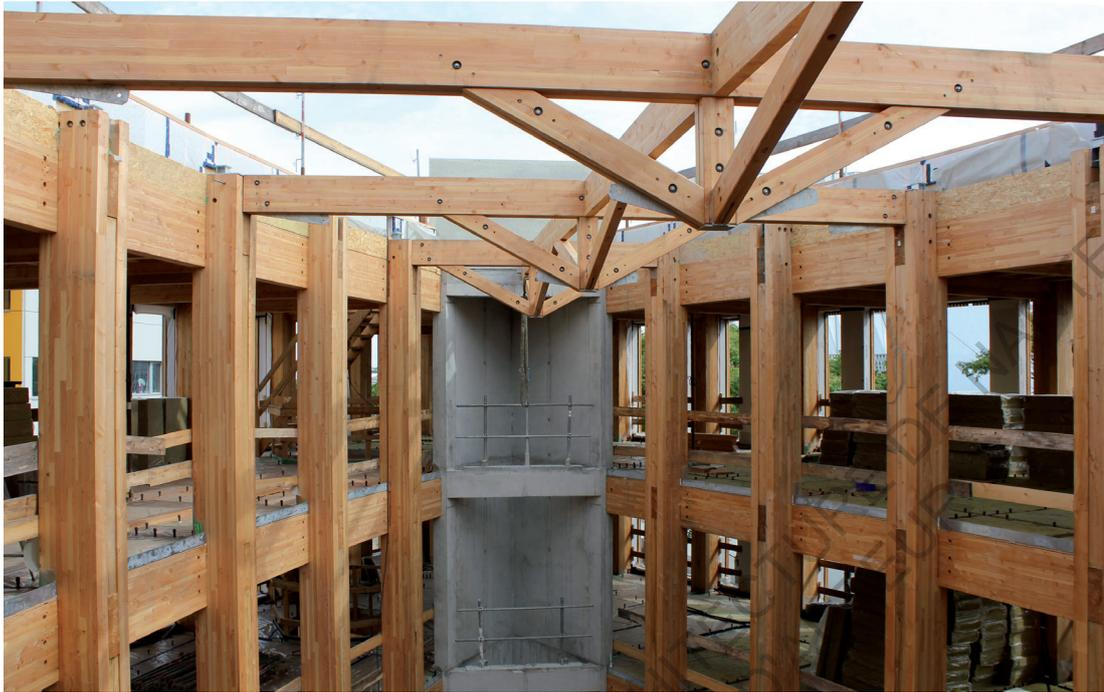
Le bâtiment B construit sur l'île de Nantes en 2014 par les architectes Barré-Lambot est le nouveau siège de l'association Atlanbois. Ce bâtiment en R+3 emploie le système constructif poteaux poutres réalisées en pin Douglas lamellé collé. Les cages d'ascenseur et d'escalier réalisées en béton permettent de rigidifier l'ensemble. ©Atlanbois (<http://www.atlanbois.com/blog/>)
