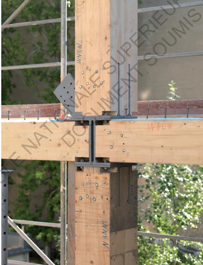
Détail d'assemblage métallique
