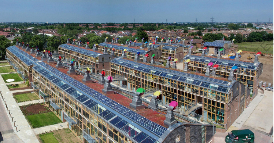
Photographie aérienne du BedZED © Bill Dunster
