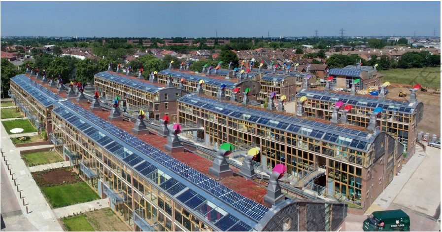
Photographie aérienne du BedZED © Bill Dunster
